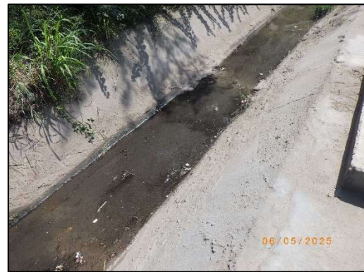
รูปที่ 2-22 การขุดลอกทางระบายน้ำ
