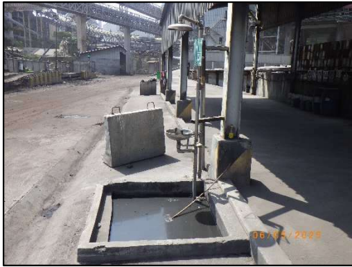
รูปที่ 2-75 อุปกรณ์ล้างตัวฉุกเฉิน
