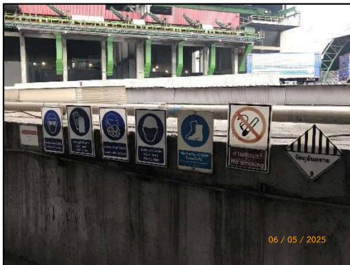
รูปที่ 2-27 ป้อคอนกรีตเก็บของเสียประเภทของเหลว พร้อมติดป้ายเตือนอันตรายต่างๆ
