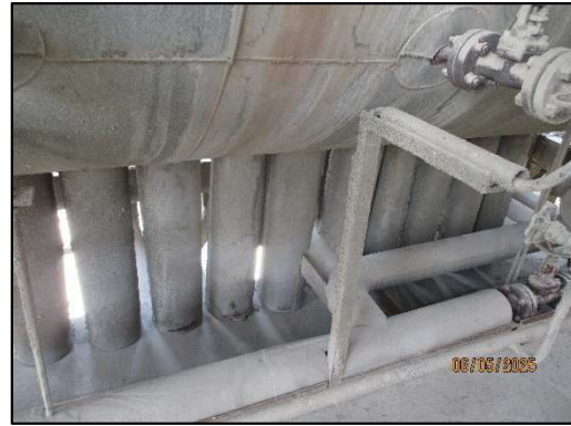
รูปที่ 2-76 ฉนวนกันความร้อน บริเวณระบบท่อไอน้ำ
