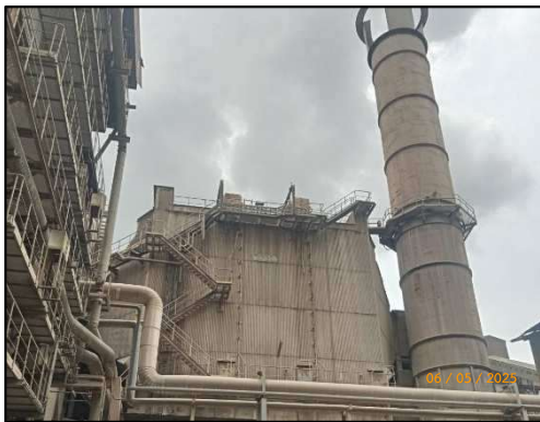
รูปที่ 2-3 อาคารอุปกรณ์ดักฝุ่นแบบไฟฟ้าสถิตย์ (1)
