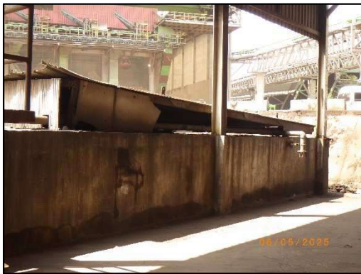
รูปที่ 2-39 บ่อดักตะกอนน้ำมัน
