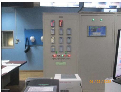
รูปที่ 2-79 การตรวจสอบระดับน้ำแบบ Electrode ซึ่งจะส่งสัญญาณมาแสดงที่ห้อง Control room ตลอดเวลา
