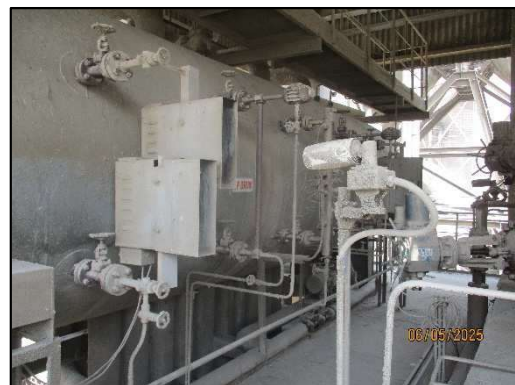
รูปที่ 2-80 เครื่องวัดระดับน้ำใน steam drum
