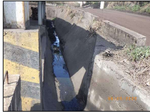
รูปที่ 2-32 รางระบายน้ำฝน บริเวณอาคารเก็บกากของเสีย
