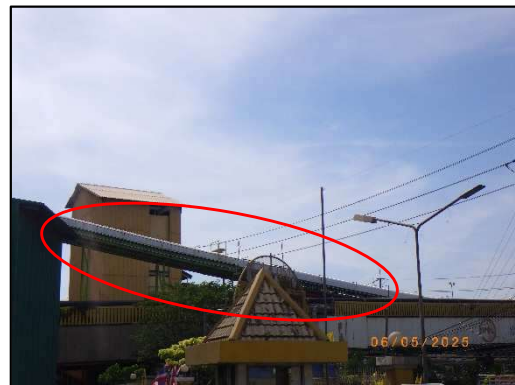
รูปที่ 2-6 การปิดคลุมสายพานลำเลียงวัตถุดิบ ข้ามถนนมิตรภาพ
