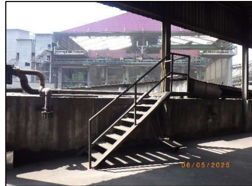
รูปที่ 2-26 มีการยกขอบป้องกันสารที่อาจหกรั่วไหล บริเวณลานสูบน้ำของเสีย
