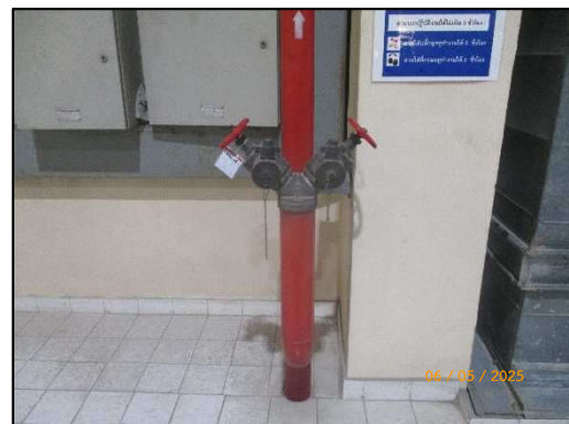
รูปที่ 2-74 อุปกรณ์ดับเพลิง (สายส่งน้ำดับเพลิง)
